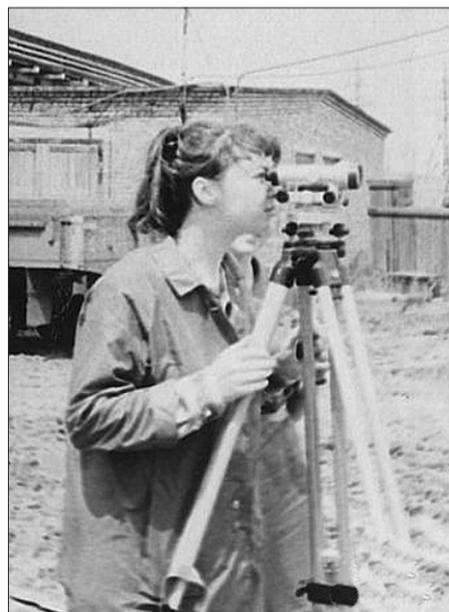
Ольга Антропова работает с теодолитом, с помощью которого измеряются углы при подготовке к строительству.
