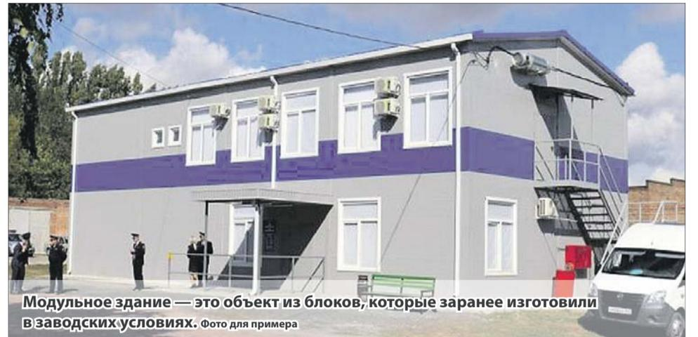
Модульное здание — это объект из блоков, которые заранее изготовили в заводских условиях. Фото для примера
