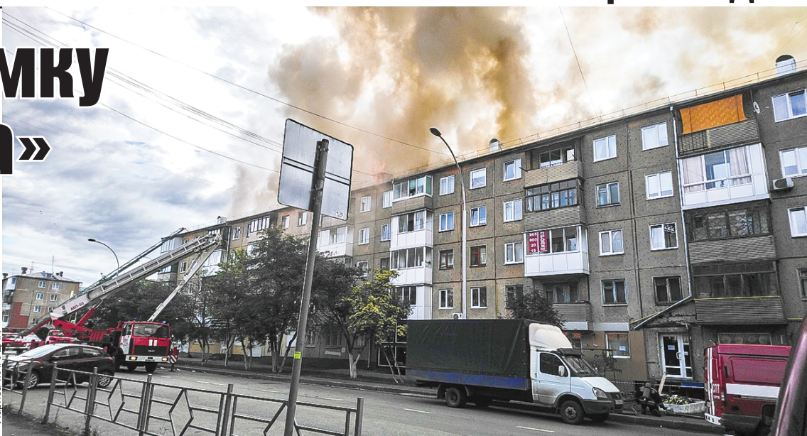
Столб дыма, поднимавшийся рано утром над пятиэтажкой, был виден издалека.
