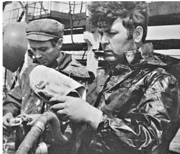
Иосиф Душанек на строительстве ПК «Шесхарис».
