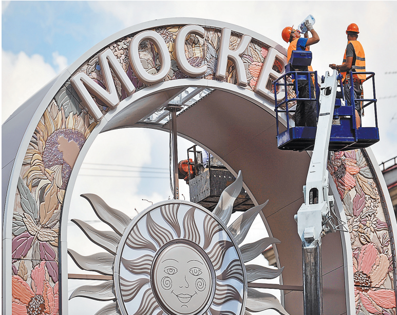
В городе заканчивают монтировать 14-метровые арки, сделанные по образцу 1947 года, — тогда подобная конструкция стояла на Пушкинской площади.
