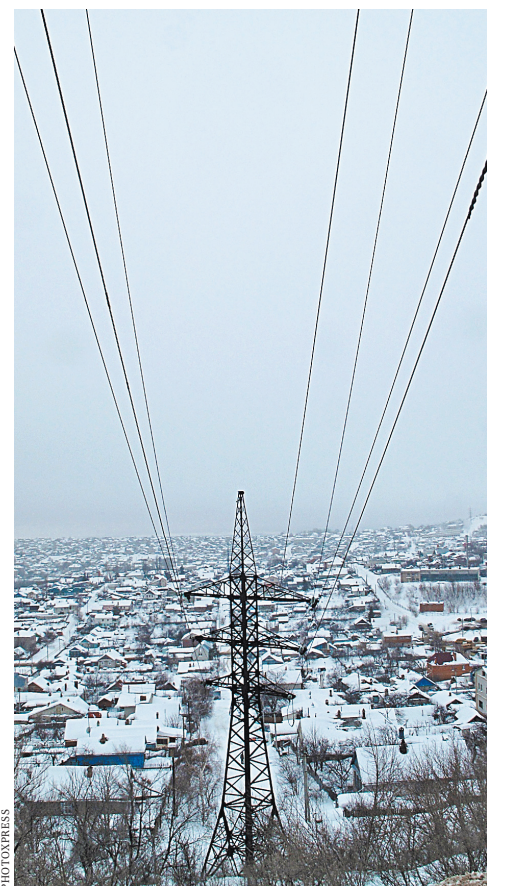
«Подвинуть» опору ЛЭП, даже если она мешает собственнику земли, не удастся.
